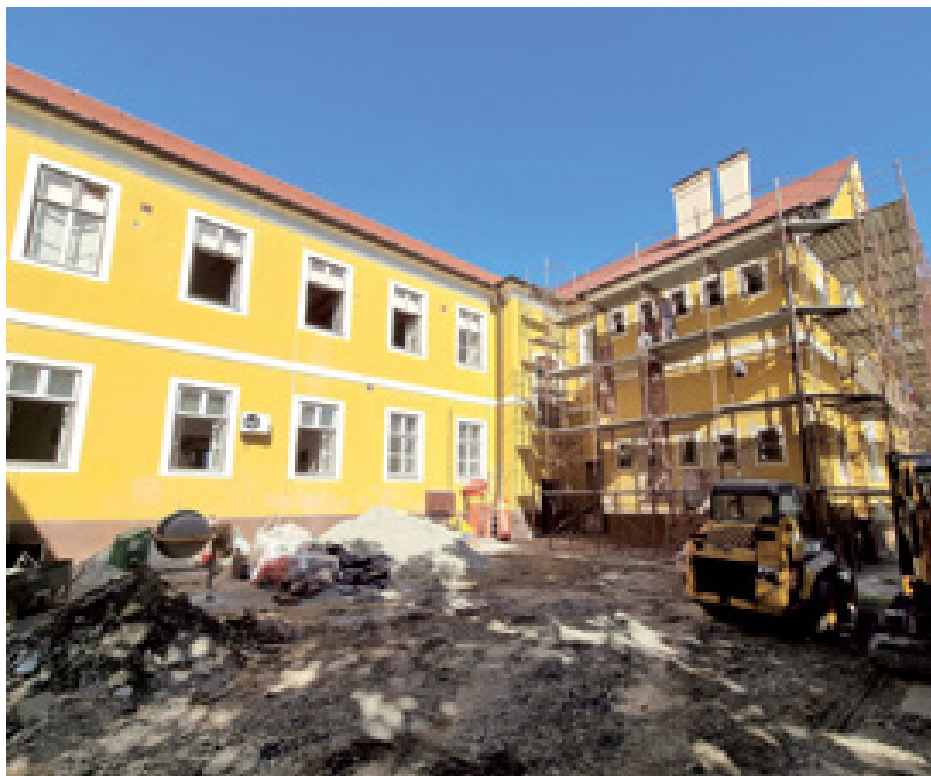
Nastavljena je obnova i zaštita stare školske zgrade.
