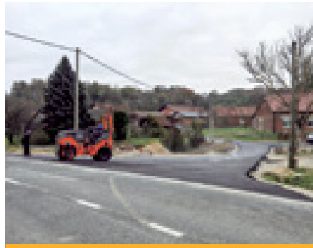
Asfaltiranje ulica nakon radova na kanalizacijskom sustavu
