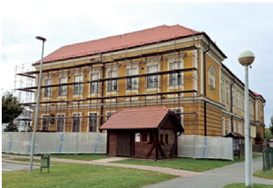
U nekadašnjoj školskoj zgradi, osim vanjskih, izvode se radovi i u knjižničnom, galerijskom i muzejskom prostoru.
