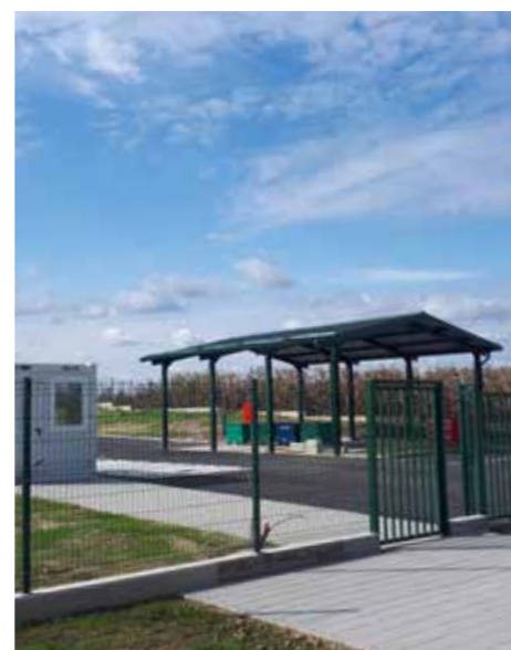
Reciklažno dvorište u izgradnji
