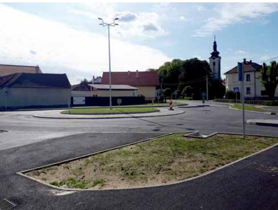
Kružni tok u Lugarićevoj u završnoj fazi izgradnje
